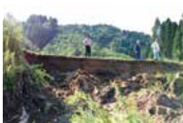
災害現場確認
